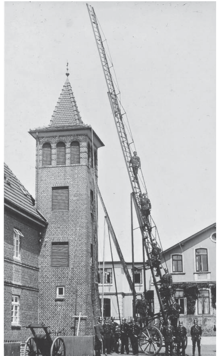
Übung mit der ersten Ausziehleiter am neuen Spritzenhaus an der Charlottenstraße im Jahr 1927.
